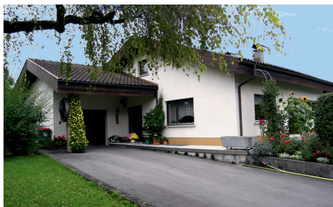
Risanamento di un impianto di riscaldamento con un Belaria® compact IR installato internamente.
