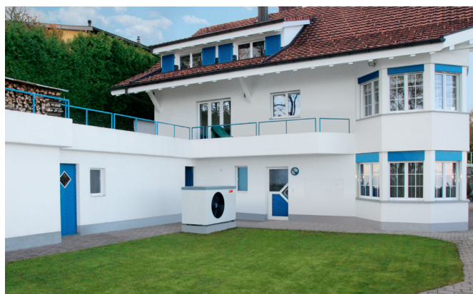
Risanamento dell'impianto di riscaldamento con un Belaria® twin A (17) installato esternamente
